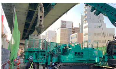
地中障害物撤去工事
