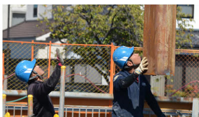
各種杭打ち工事（鋼矢板他）
