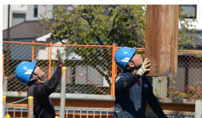
各種杭打ち工事（鋼矢板他）
