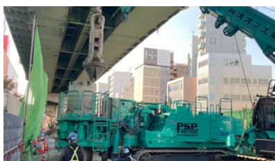
地中障害物撤去工事
