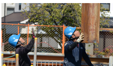
各種杭打ち工事（鋼矢板他）
