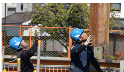
各種杭打ち工事（鋼矢板他）
