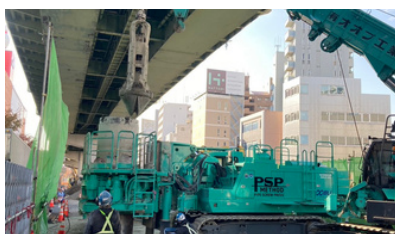
地中障害物撤去工事
